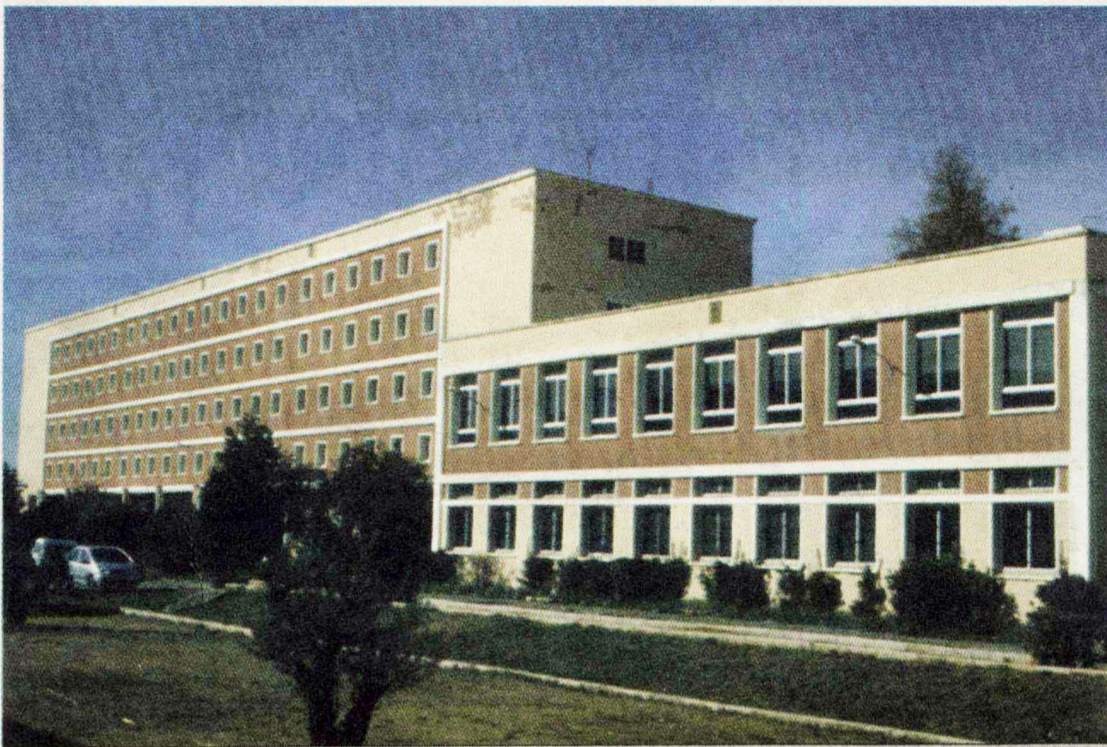
AULARIO DE LA UNIVERSIDAD. Vista de la fachada transformada.
