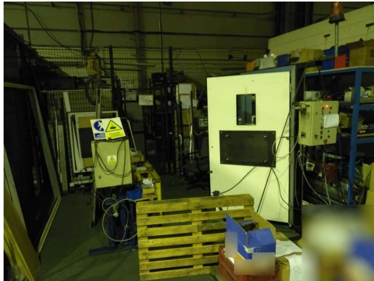
16. Zona previa del mantenimiento antes de su reubicación.
