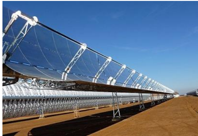
Figura 48. Planta cilindro parabólica. 8
