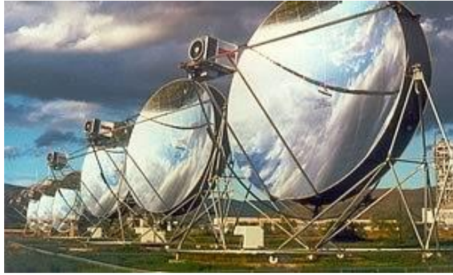
Figura 46. Planta de disco parabólico. 6
