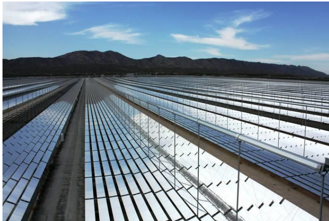
Figura 47. Planta de reflectores lineales Fresnel. 7
