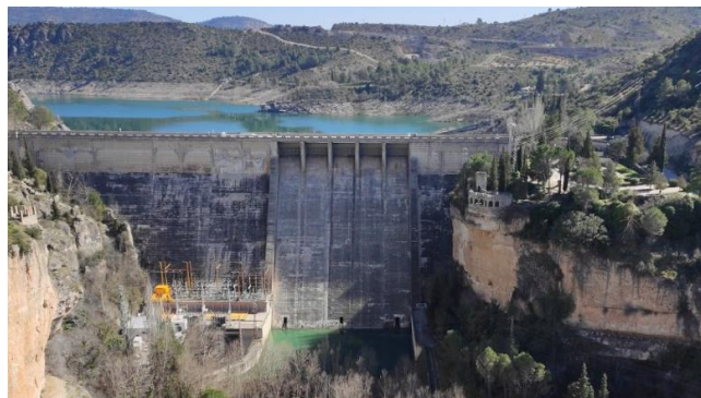
Ilustración 5: central hidroeléctrica del embalse de Entrepeñas (Fuente: Google Street View)
