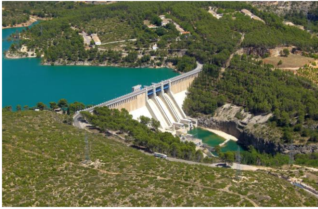
Ilustración 6: central hidroeléctrica del embalse de Alarcón (Fuente: https://www.cobraih.com/ )
