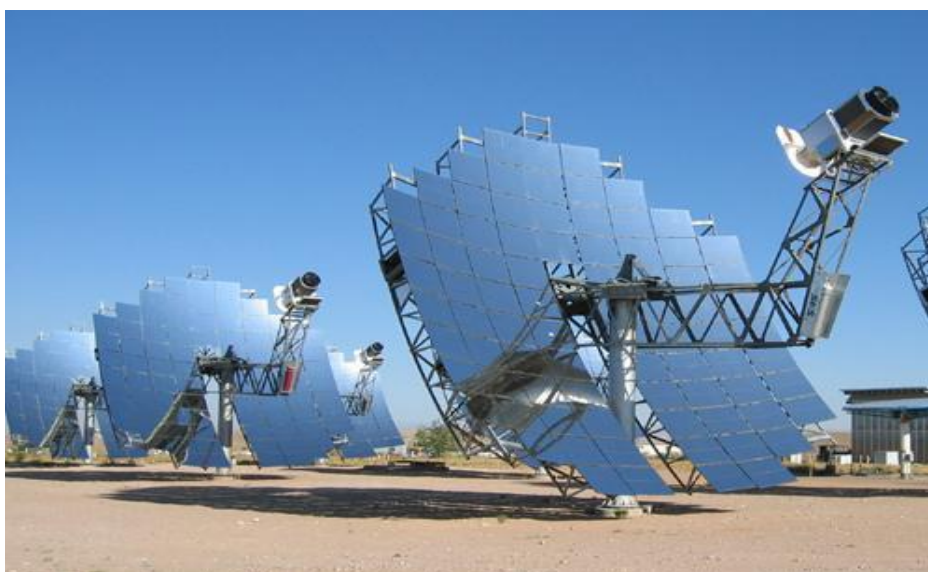
Figura 6 - Central termosolar con discos parabólicos de Stirling (LACYQS, 2015)
