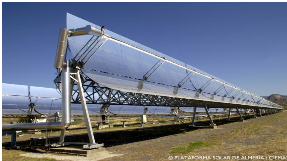
Figura 3 - Central termosolar de canales parabólicos
