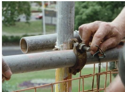
*Imagen 22: Barandilla atada mediante alambres.
