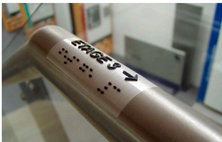
Figura 26. Placa de señalización Braille en pasamanos.
