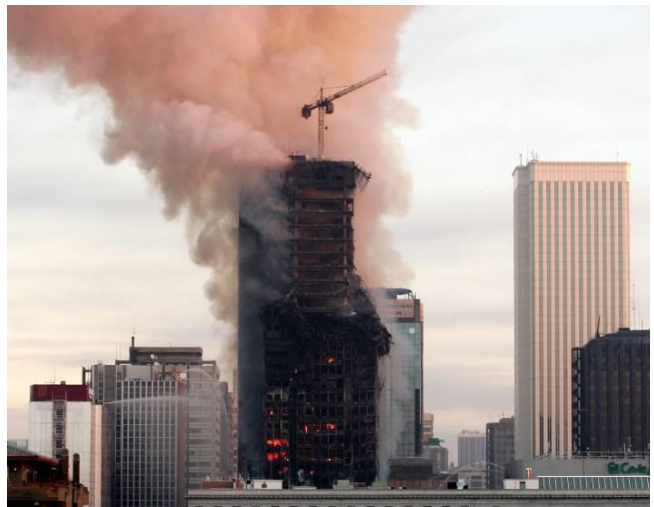
Figura 2. Incendio Torre Windsor (elpais.com)
