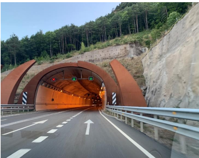
Figura 9. Túnel carretero (es.wikipedia.org)
