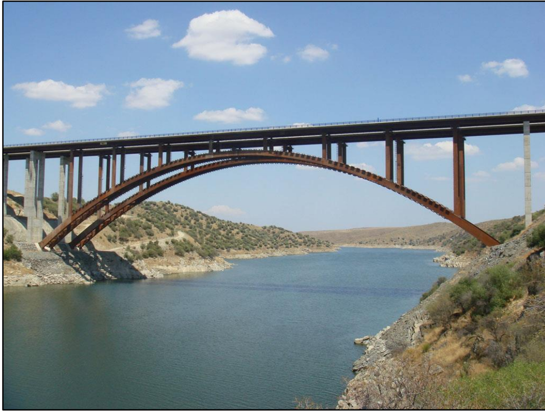
Figura 1-5. Puente de Alconétar en la autovía A66 (Cáceres)
