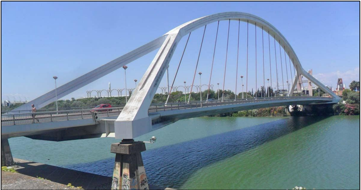
Figura 1-7. Puente de la Barqueta (Sevilla)
