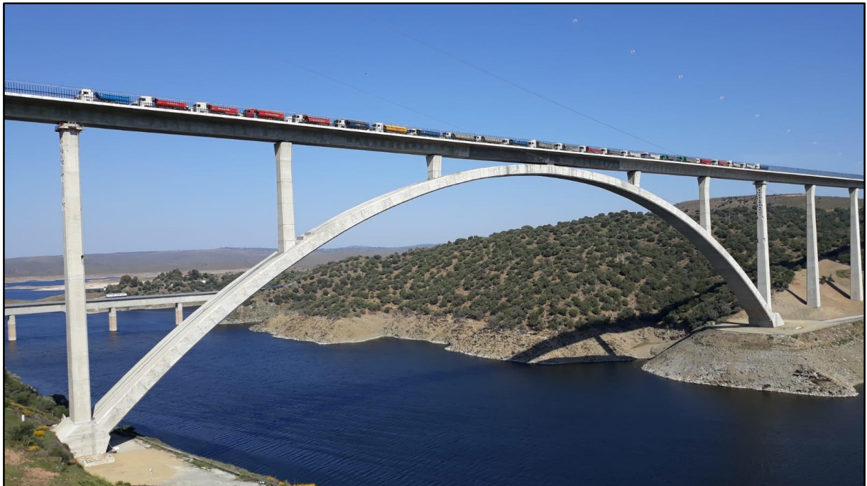
Figura 1-4. Puente arco viaducto LAV Madrid-Extremadura-Frontera Portuguesa
