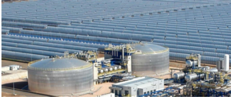
Figura 20 - Tanques de almacenamiento en una planta de CCP (Google imágenes)
