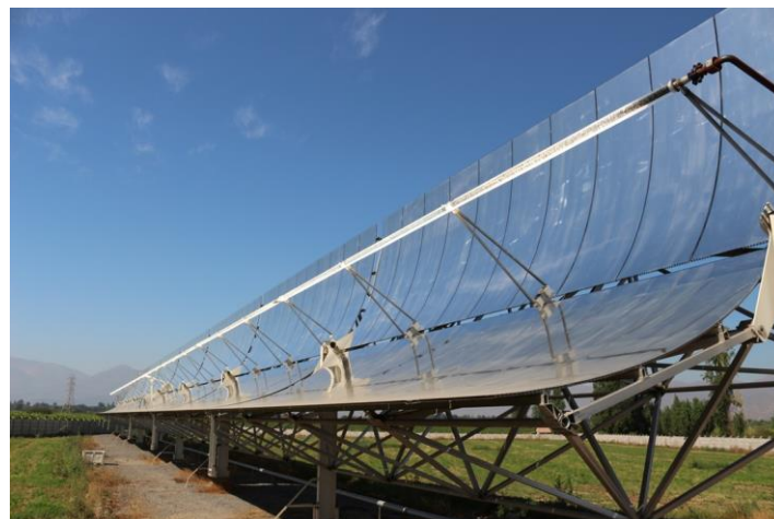
Ilustración 2. Instalación de captadores cilindro parabólico [3].
