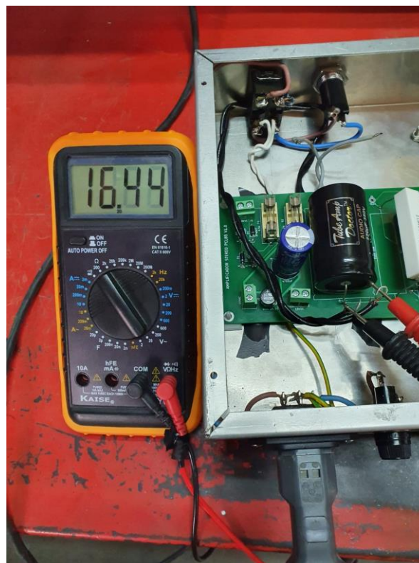
Figura 3-22. Medición del voltaje del secundario de filamentos.
