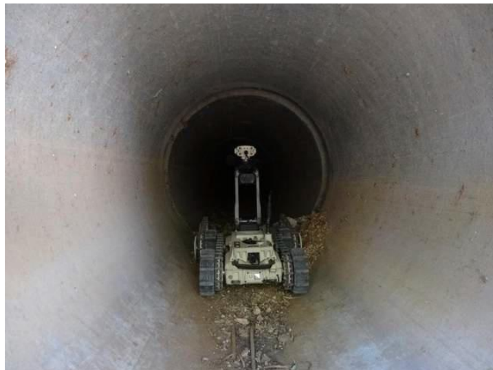
Ilustración 1-1.1 Robot subterráneo usado en la exploración de una tubería.
