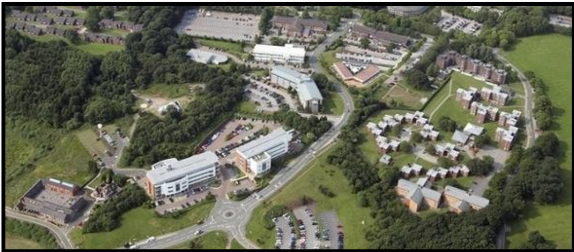
Ilustración 7. Universidad de Keele, Reino Unido con uso doméstico de la red de gas natural con hidrógeno inyectado. Fuente: Hydeploy (UK)
