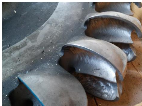
Figura 4-9: Cazos del rodete de la Central de Dúrcal erosionados por la sílice del agua.
