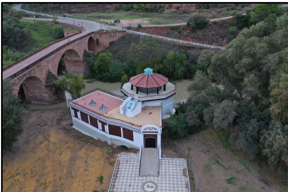
Figura 2-3: Fotografía del balneario actual y puente, abril 2019
