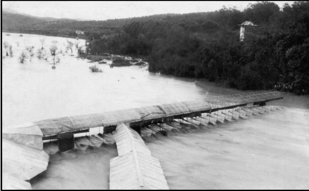
Figura 2-9: Fotografía histórica de la galería del balneario tomada desde el puente de San Bartolomé
