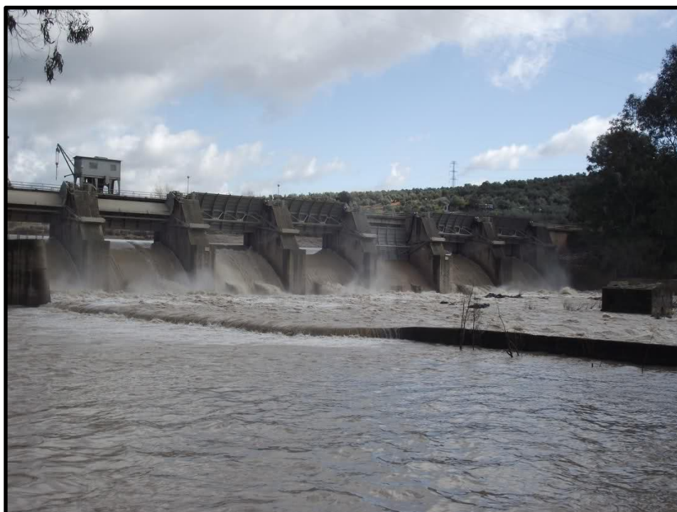
Figura 2-5: Presa de Marmolejo
