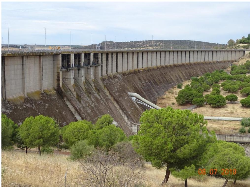
**Figura 32. Presa de Alange (Badajoz). Inaugurada en 1995, es una de las últimas grandes presas construidas en la cuenca del Guadiana. Consta de una central hidroeléctrica que se utiliza cuando hay vaciado de agua para regadíos de las vegas bajas del Guadiana.**
