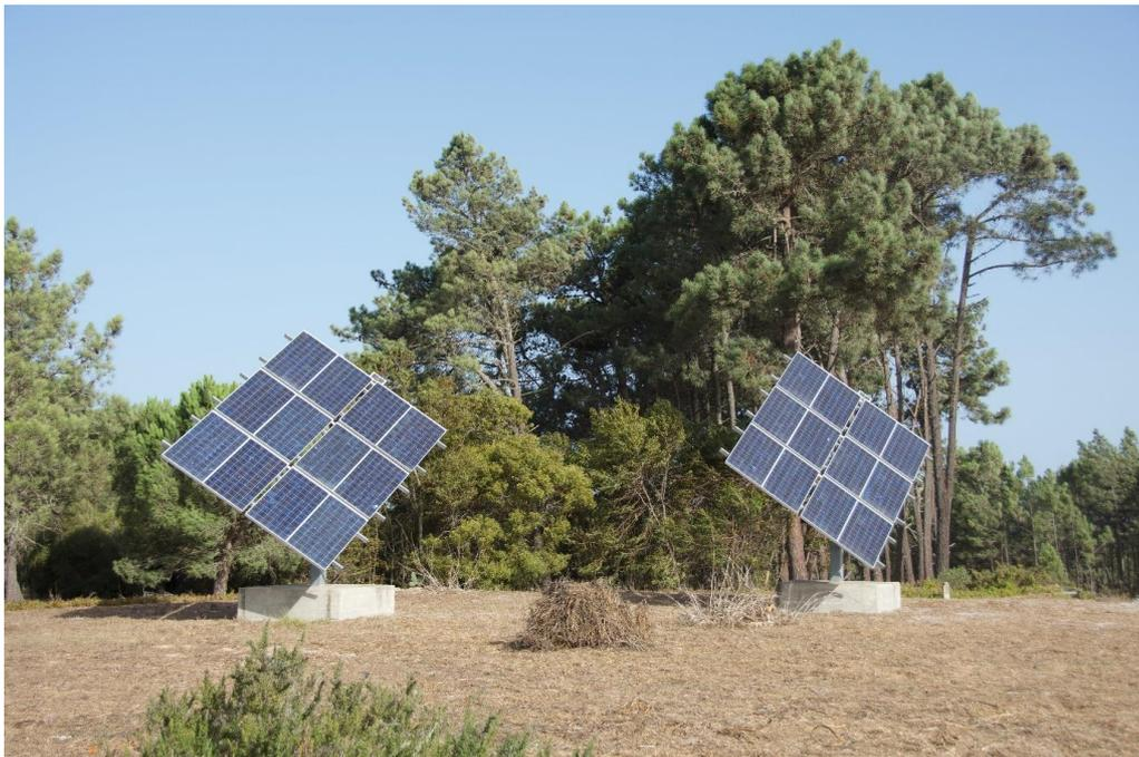
**Figura 31. Placas fotovoltaicas orientables para generación de electricidad instaladas en la Costa Vicentina, Portugal.**
