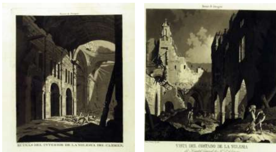
Figura 11, Costado de la Iglesia, Ruinas de Zaragoza, Gálvez y Brambila.
