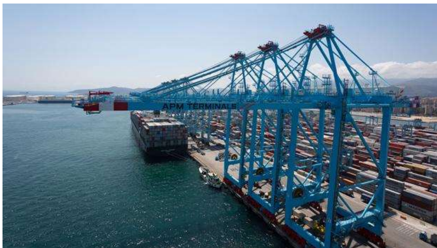
Ilustración 4.9 Grúas pórtico en el muelle Juan Carlos I
