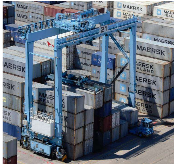
Ilustración 4.11 Grúa RTG en el Puerto de Algeciras
