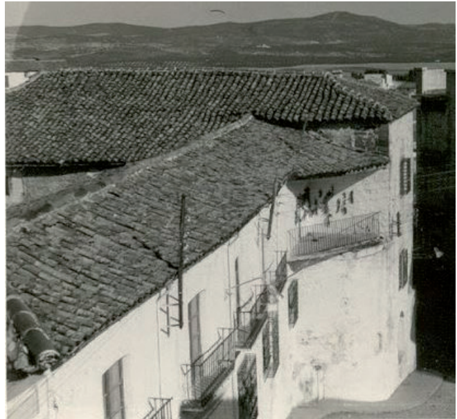
Figura 4. Casa-palacio de los Benavides en Santisteban del Puerto, poco antes de su demolición. Fuente: Fotografía de autor desconocido < http://gabrielsagra.blogspot.com/2014/09/palacio-de-los-duques-de-santisteban.html >
