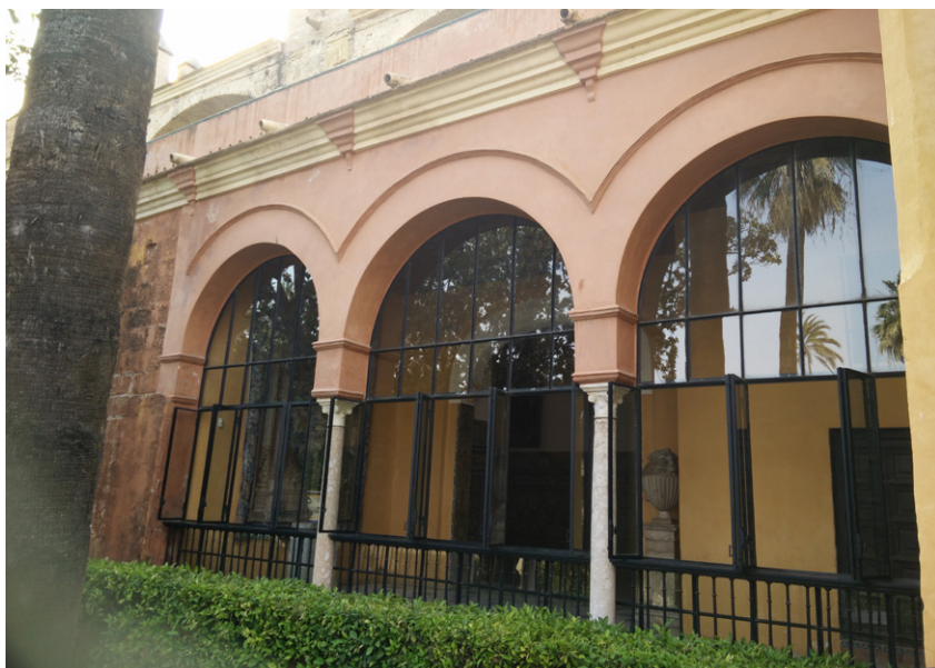
Figura 3. Galería de salida de la Sala de las Bóvedas.
