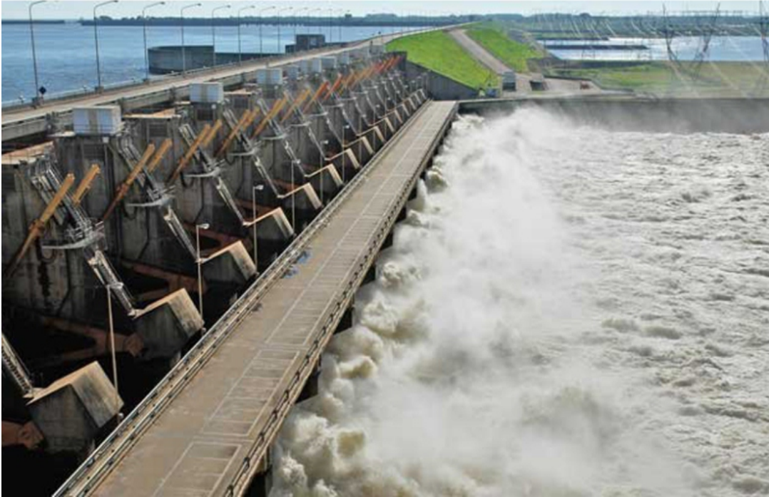
Figura 1.3 Central Hidroeléctrica Yacyretá [11].
