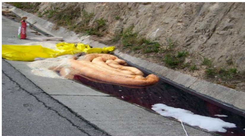
Figura 26. Imagen de derrame cubierto con arena y otros elementos de retención. Fuente: [30]
