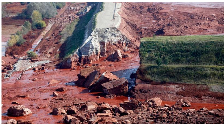
Figura 8. Vista aérea del dique de contención que cedió liberando el lodo rojo en Ajka (Veszprém, Hungría). Fuente:[18]
