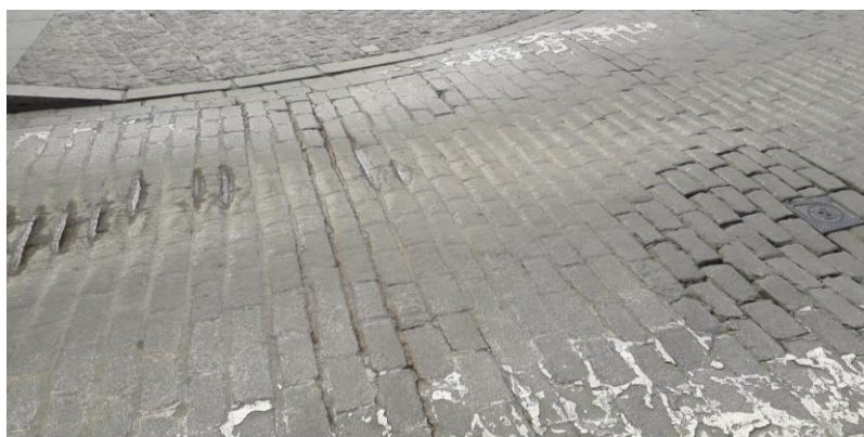
Figura 5-9. Deterioro del pavimento asfáltico y de adoquines de granito originadas por caballos (Parque María Luisa).
