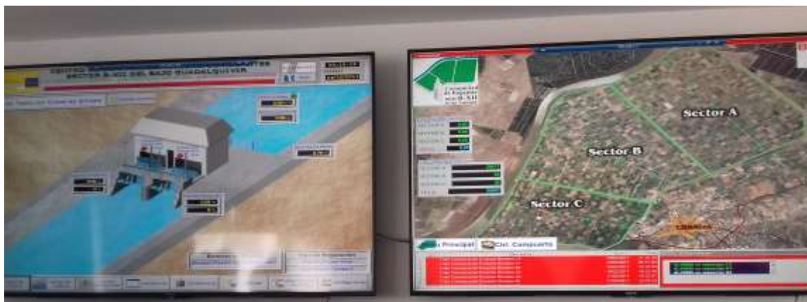
Fotografía tomada en el edificio de control de la C. R sector B-XII, en marzo de 2017
