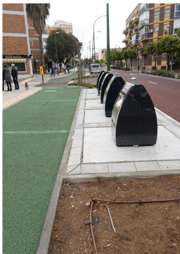
Imagen 28. Equipamiento recogida de RSU
