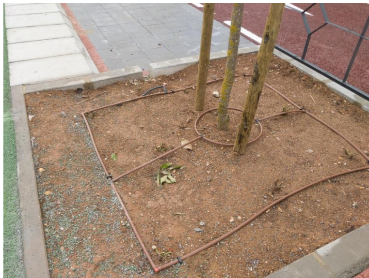
Imagen 12. Sistemas de riego en superficie (Mazuela Pérez, 2018).
