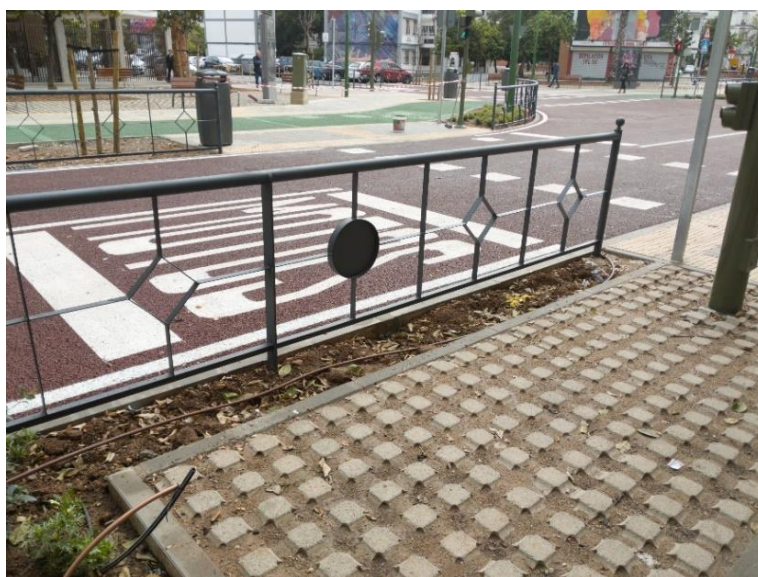
Imagen 7. Zonas de pavimento modular vegetado (Mazuela Pérez, 2018).
