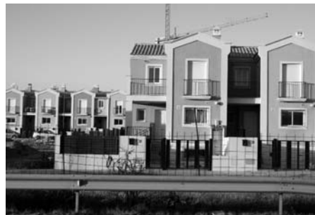
16. Santa Rosalía, la propuesta construida como definidora de la fachada a la A-357
