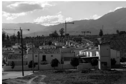
21. Zalea. Vista General de la intervención desde la parte baja del pueblo
