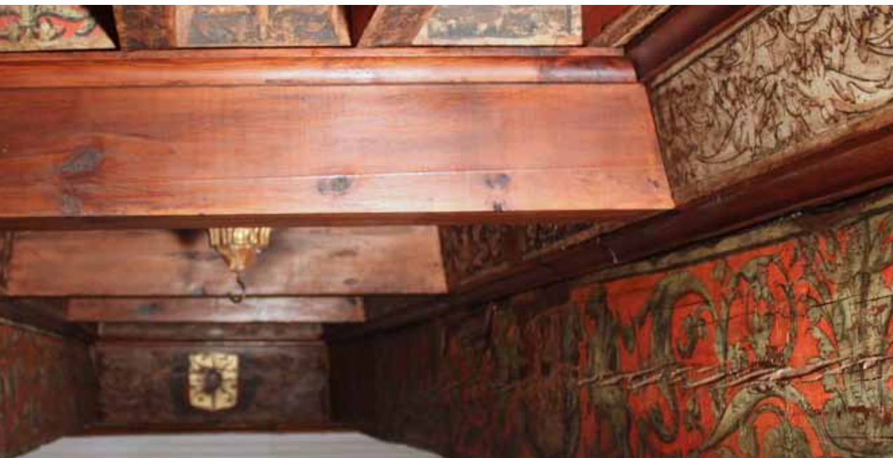
Figura 88. Estado final. Vista de la calle central
