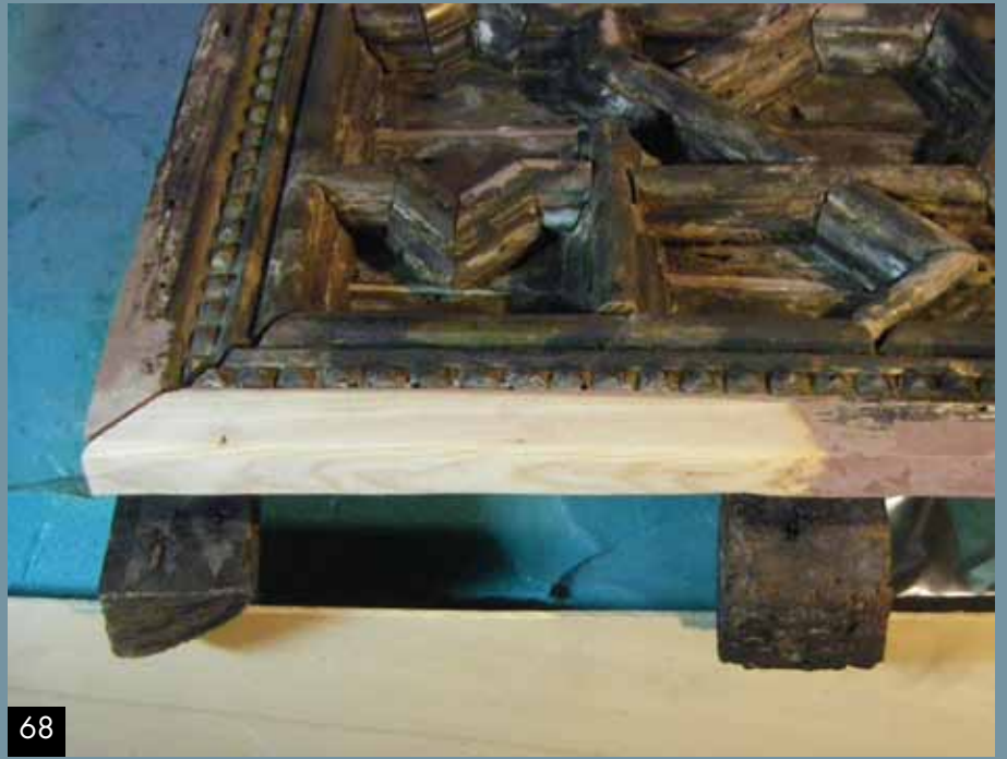
Figura 67. Consolidación estructural de cintas y verdugos sobre viguetas
