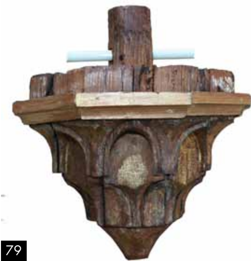
Figura 76. Testigo de limpieza de la macolla de mocárabes central
