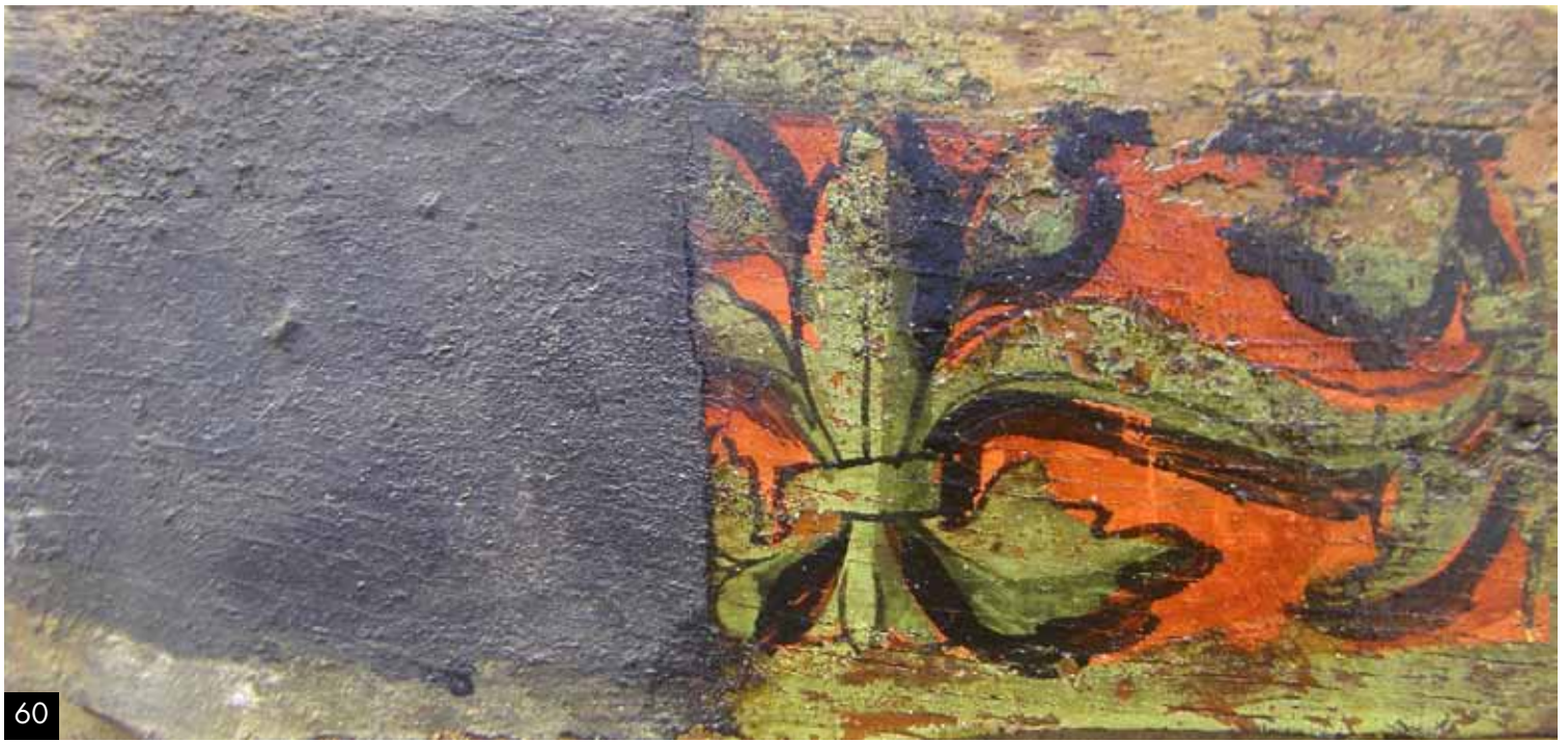
Figura 60. Limpieza del barniz oscuro en tabiquillo
