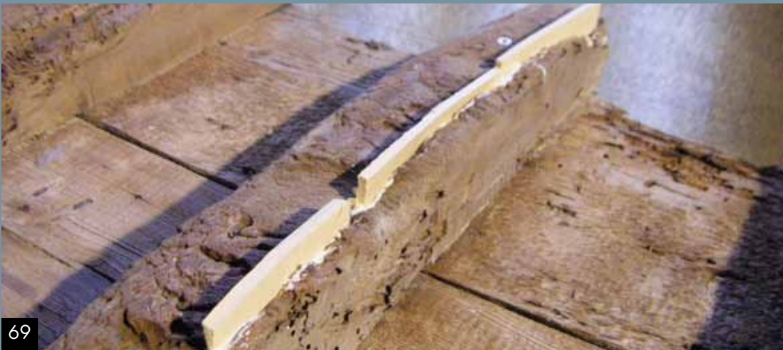
Figura 67. Consolidación estructural de cintas y verdugos sobre viguetas
