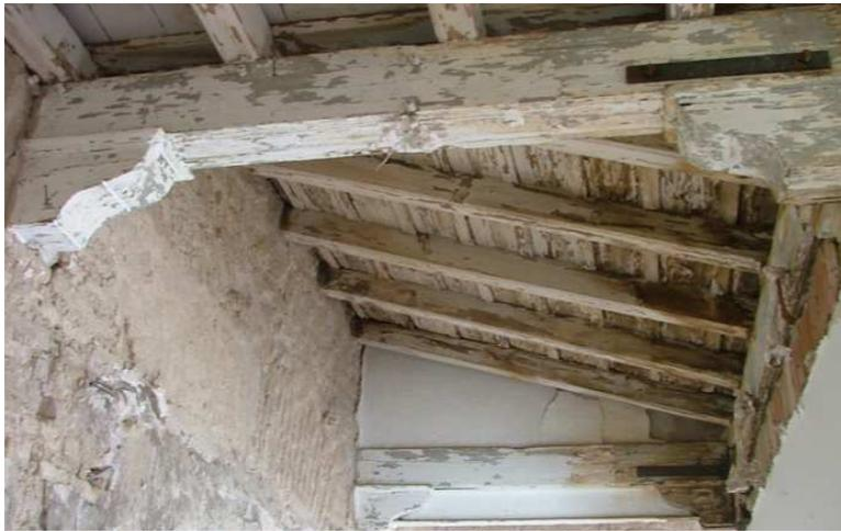
**Galería Norte de patio principal, planta alta. Originalmente se cubría por medio de forjado a un agua con apoyo de cuchillo en sus ángulos. Esta disposición quedó reforzada mediante vigas de hierro en los años 40, en ese periodo también quedan ocultos por techo de escayola.**
