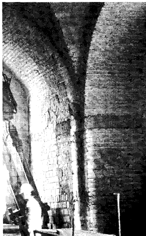
Figura 6 Detalle de bóvedas de arista en la planta baja del Cuartel de la Puerta de la Carne de Sevilla
