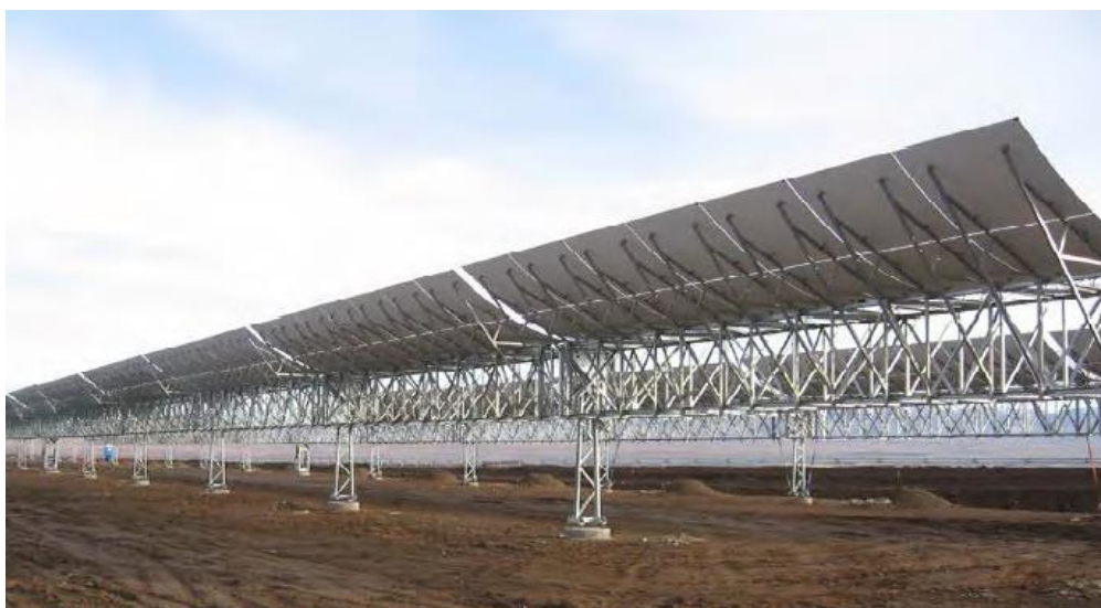
Figura 13. Filas de colectores SKAL-ET en la planta solar Andasol-1
