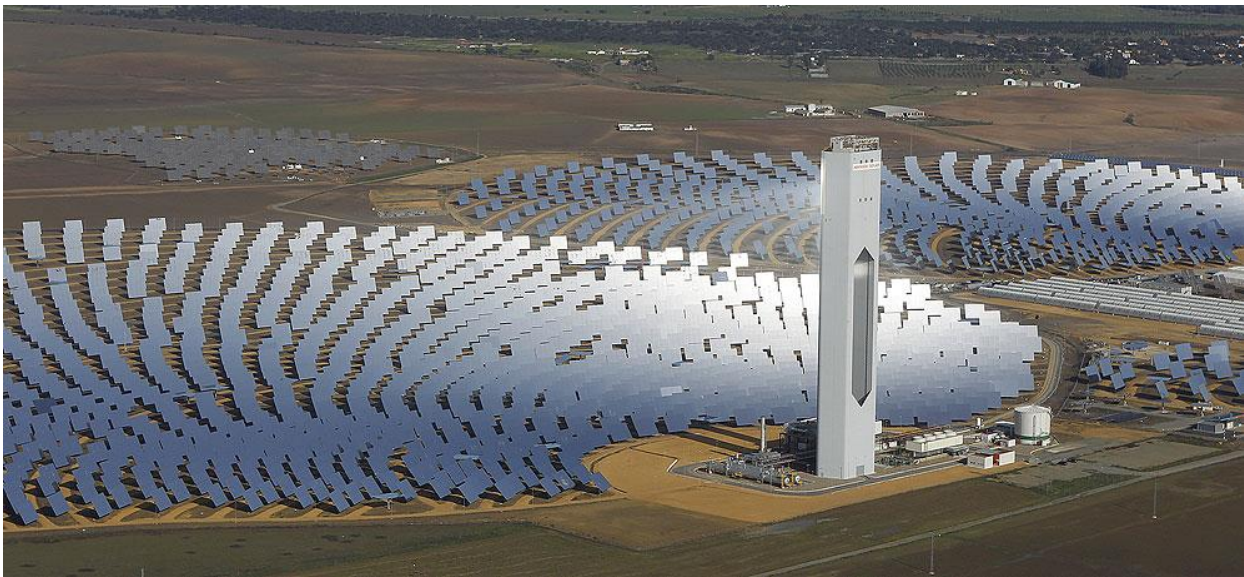
Figura 6. Sistema de Torre Central
