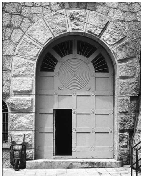
Puerta de entrada a la sala de turbinas
