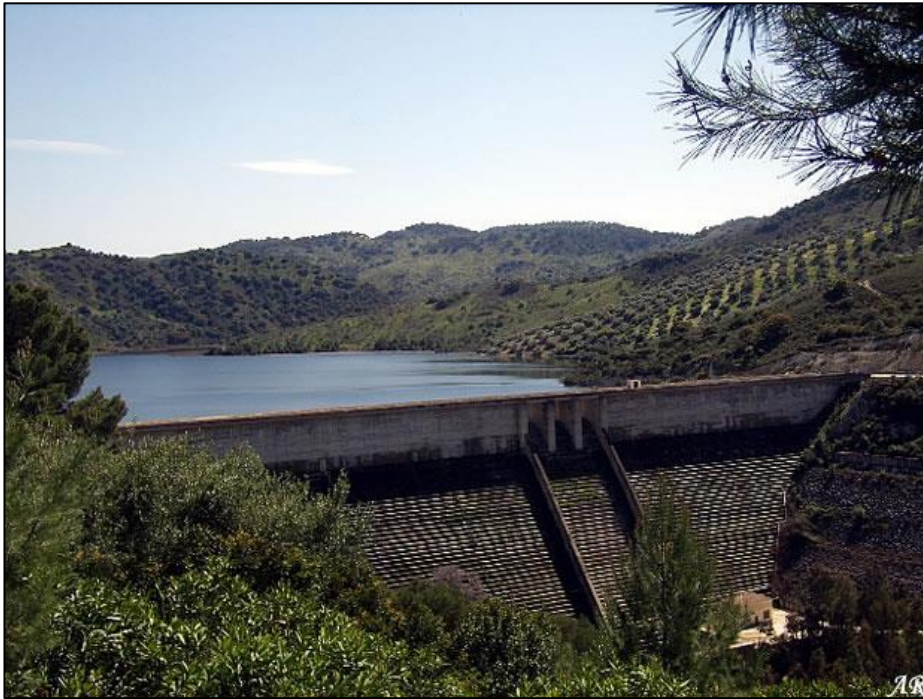
Ilustración 1: Presa de la Puebla de Cazalla con aliviadero en coronación
