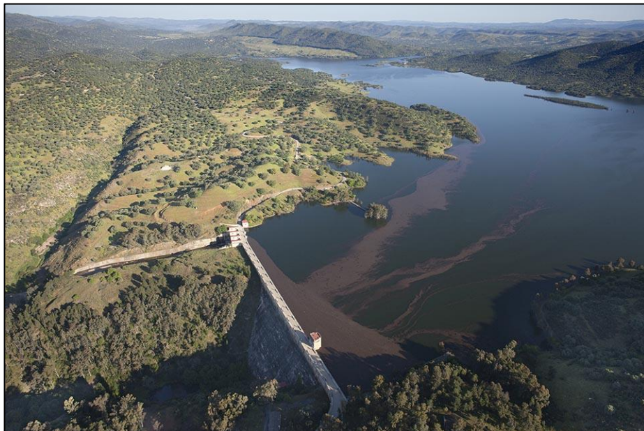
Ilustración 2: Presa del pintado con aliviadero independiente
