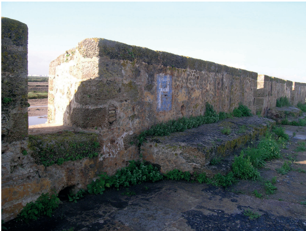
FIGURA 2. BATERÍAS DEFENSIVAS DEL S. XVIII USADAS COMO APARCAMIENTOS
