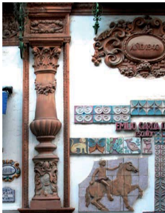
6. Casa N° 10 de la calle Antillano Campos, detalle de la fachada. 1940. Fábrica de Montalván. Foto: Pedro M. Martínez Lara.
