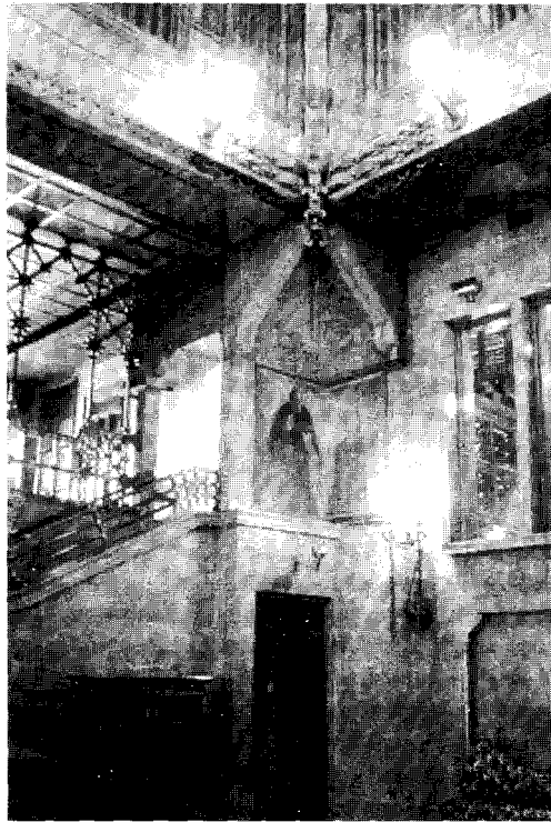
Figura 11 Imagen de la escalera en el lugar de la sección anterior
