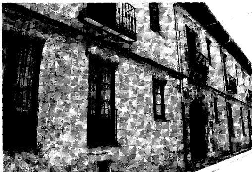
Fig. 3. León. Antigua casa del cabildo catedralicio en la calle San Pelayo.
