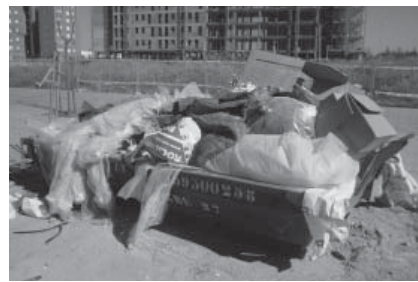
Figuras 3.14-3.18. Fracciones de hormigón, madera, metales, yeso y mezcla de plásticos y papel y cartón en las obras de estudio.
