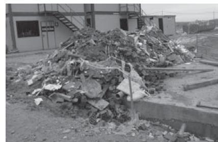
Figuras 3.10-3.13. Recogida de los RCD mediante cubilotes, acopio de RCD peligrosos en recipientes especiales, acopio de RCD no peligrosos en cubas y acopio de RCD no peligrosos en montones
