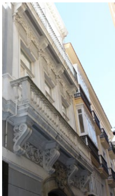
Fachada a c/ Novena
