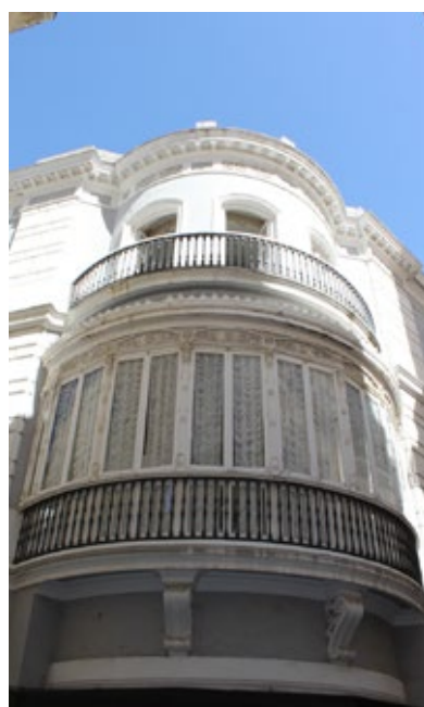
Fachada a c/ Ancha
