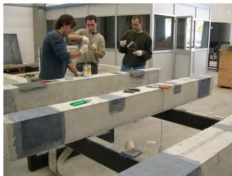
*Fig. 3. Pegado de la platabanda de fibra de carbono sobre vigas de hormigón armado.*
