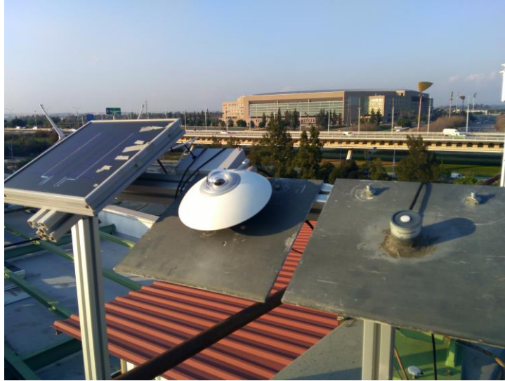
Ilustración 69: Estación instalada por el grupo de energéticos
