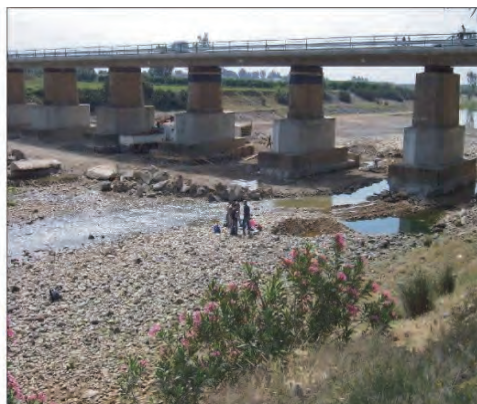
Figura 1: (a) Alteración del régimen fluvial por incremento en la regulación de la cuenca; (b) Perspectiva del cauce en la actualidad, en la transversal del Guillena: patrón morfológico de cauce efímero con carga tractiva (gravas y bloques) y consecuencias en la infraestructura viaria.
