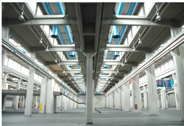
Figura 9. Officine di Smistamento . Unión de dos naves laterales. Lucernarios (fotografía del autor, 2005).
