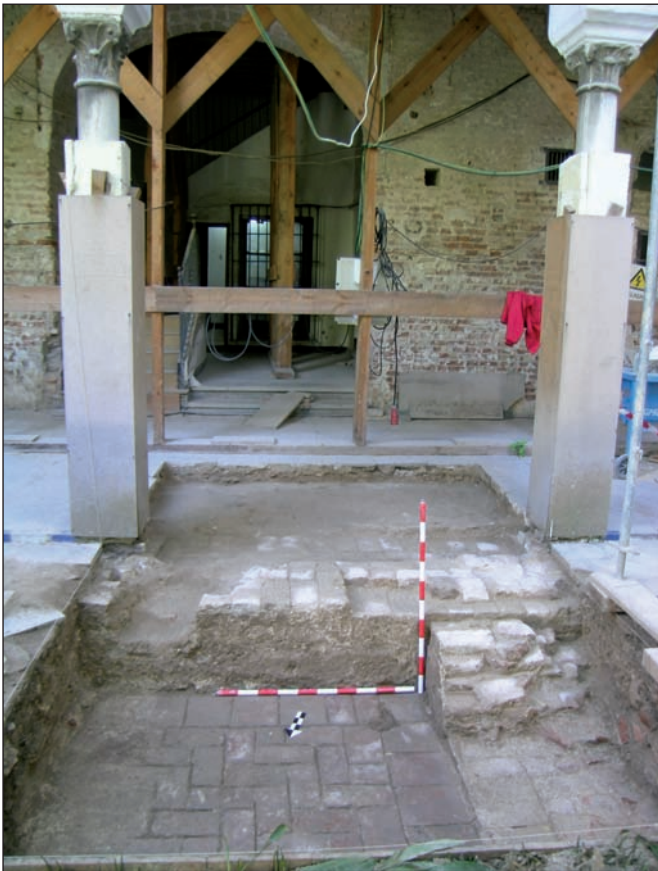
Fig. 9. Arco original de acceso a la zona principal del palacio en el testero Sur del edificio. En primer término se observan los restos de la alberca central, bajo la actual solería del claustro, que recorría el patio de Norte a Sur y sobre cuyo muro de cabecera se asientan actualmente las columnas de la galería renacentista
