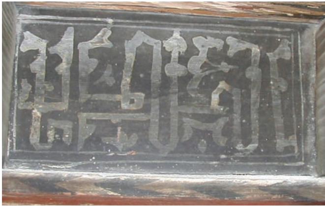
Figura 16. Detalle de las tabicas del forjado que divide en dos la altura original del edificio del infante ubicadas en la estancia 80
