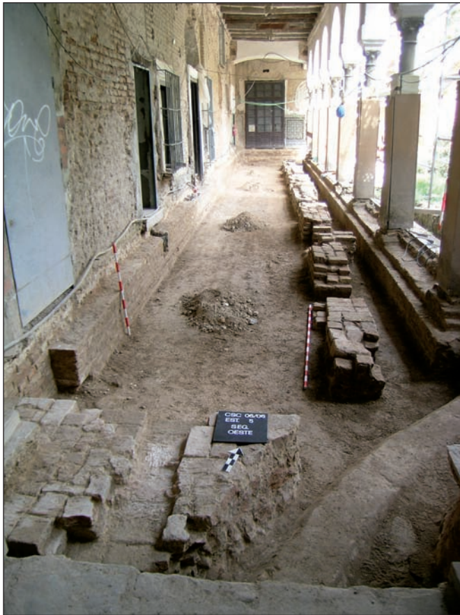
Figura 18. Imagen tomada desde el extremo Suroeste del actual claustro (estancia 5) en la que se distingue la cimentación de la galería del primer claustro en paralelo a la actual. En primer término se observa el extremo del muro de cabecera meridional de la alberca del palacio del infante cortado por una atarjea posterior
