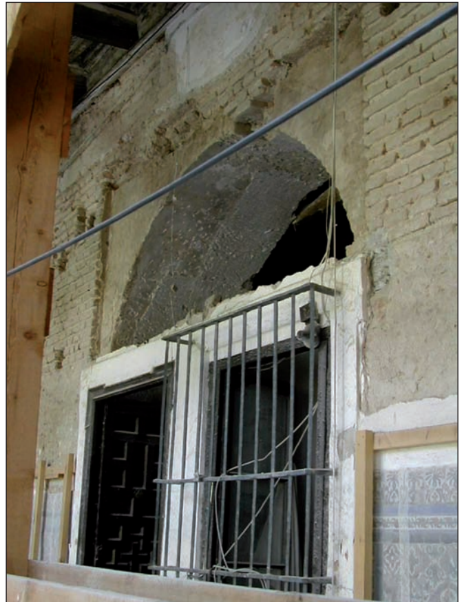
Fig. 12. Arco enmarcado por alfiz formando parte del paramento original del edificio de Don Fadrique. Se trata del acceso a la estancia hoy denominada Celda Prioral
