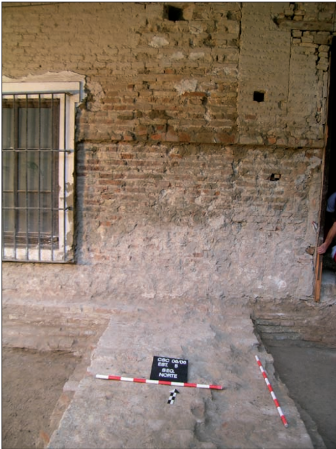
Fig. 6. Testero Norte del claustro del convento con la huella del muro que limitaba el recinto palatino al Este. En primer término se advierte el cimiento de dicho muro aparecido bajo la cota del pavimento del claustro. A la izquierda de la imagen el aparejo de ladrillo a tizón que forma la fachada del palacio y a la derecha la interfaz de adosamiento entre este edificio y la cadena de ladrillos del nuevo paramento de tapial que conforma el actual claustro
