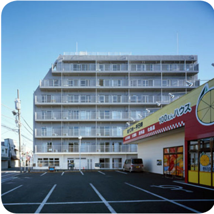
Edificio Sayana Flats (Tokio). Vista exterior previa a la intervención del arquitecto Jo Nagasaka (Fte: www.sschemata.com).
