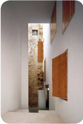
Rehabilitación en El pópulo. Cádiz.
