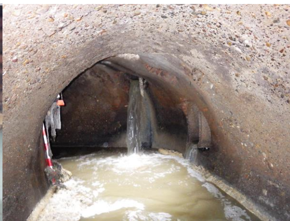
Figura 2-2. Nivel de agua de las conducciones.
