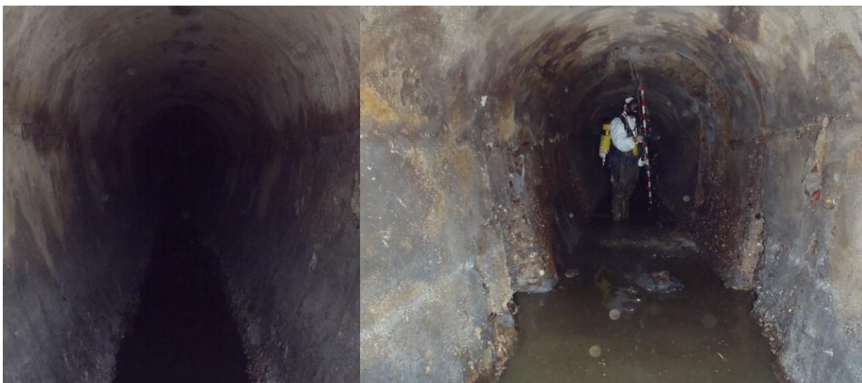
Figura 2-5. Condiciones de iluminación. Figura 2-6. Inspección con equipos de respiración.
