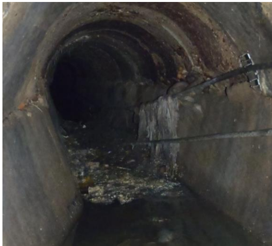
Figura 2-3. Atoramiento de la conducción.
