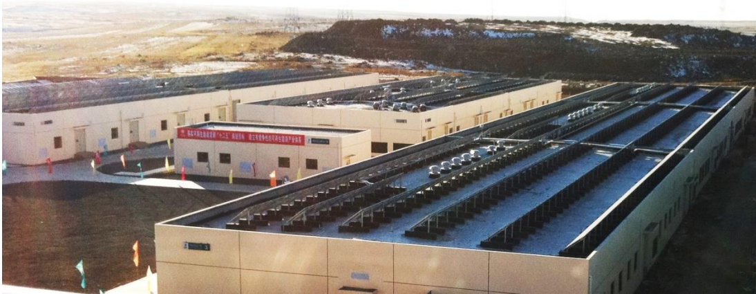
Figura 2.7. Sistema de Almacenamiento más grande del Mundo basado exclusivamente en Baterías (Zhangbei, China) [41]
