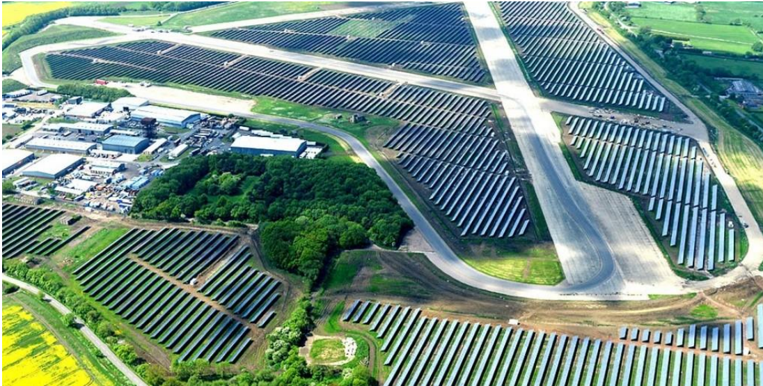
Figura 2.5. Planta Fotovoltaica de S.A.G. Solar en Alemania [18]
