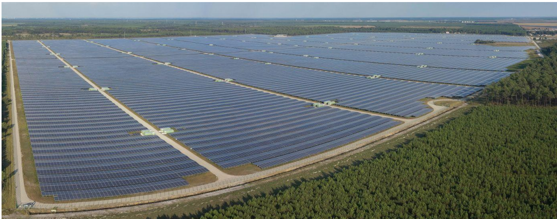
Figura 6.66. Planta Fotovoltaica de Cestas (Burdeos, Francia) de 300 MW
