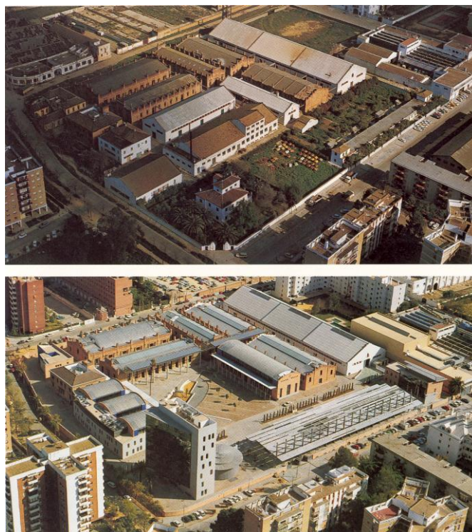
Figura 17. Fotografía del conjunto antes y después de la rehabilitación. (Fuente: SV60 Cordón & Liñán Arquitectos)
