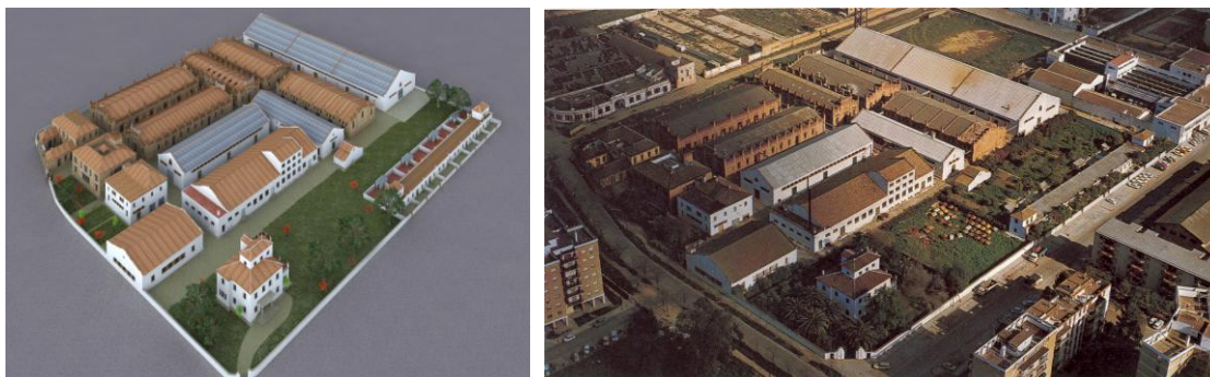
Figura 22. Vista aérea. Comparación modelado 3D y foto previa a la demolición de los edificios.
