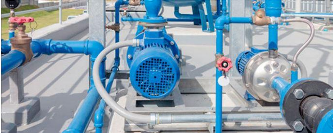
Figura 1-2: Bomba centrífuga. (Fuente: Página web cursosindustriales.es.)
